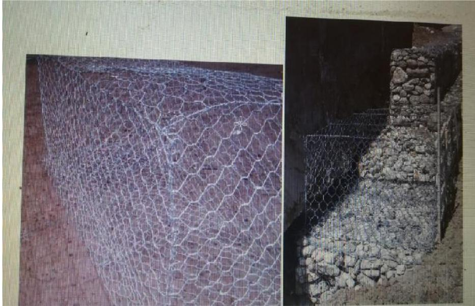
**Photo 21:** Disposition des barrages en gabions galvanisés
