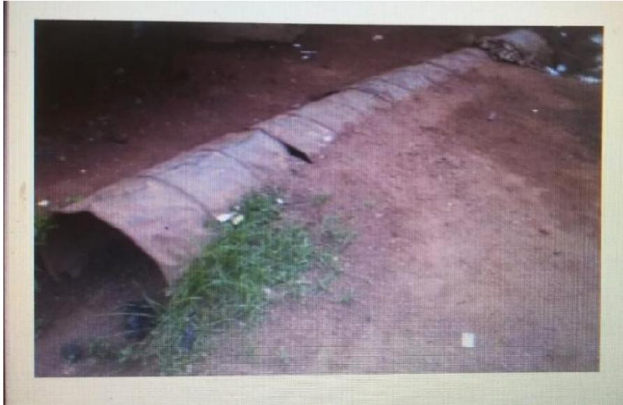
**Photo 20:** Disposition d'une diguette en assemblage de tonneaux.
