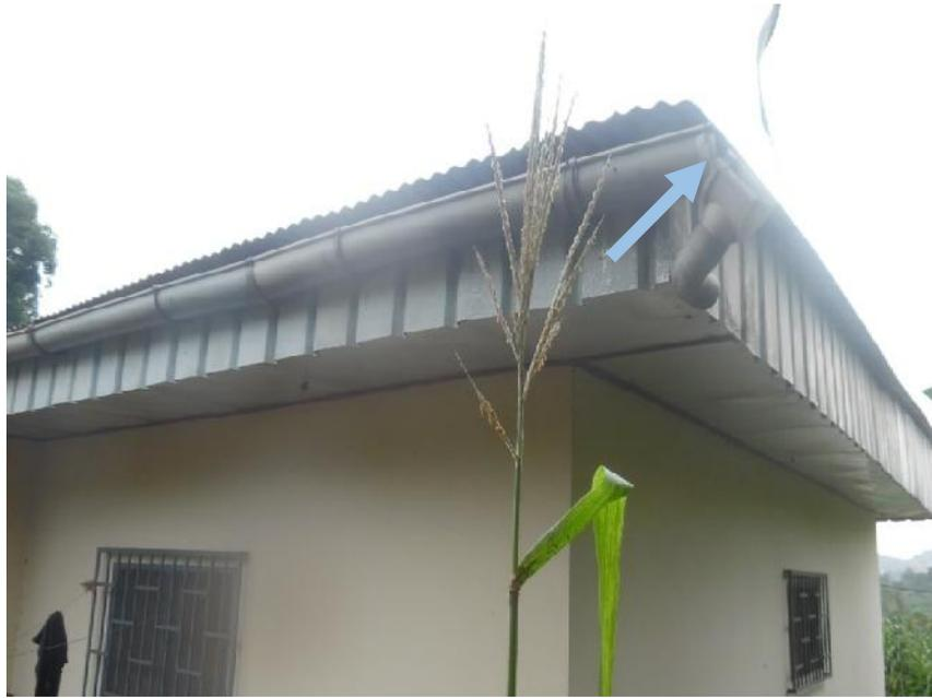
**Photo 9:** Aménagement d'une gouttière à Kamgo dans l'arrondissement de Poumougne.
