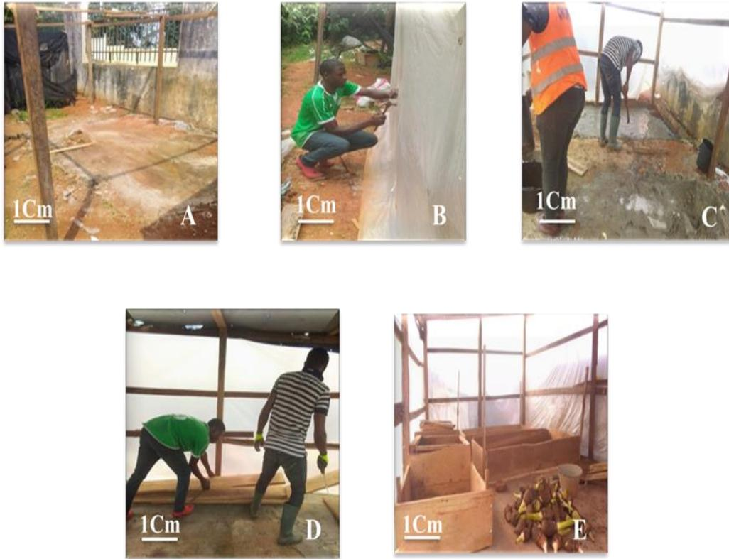
**Figure 8.** Construction de l'ombrière et des germeoirs. A= site de construction et mise en place des poteaux ; B= pose de plastique ; C=coulage du sol ; D= construction des propagateurs ; E= ombrière et germeoirs construits.
