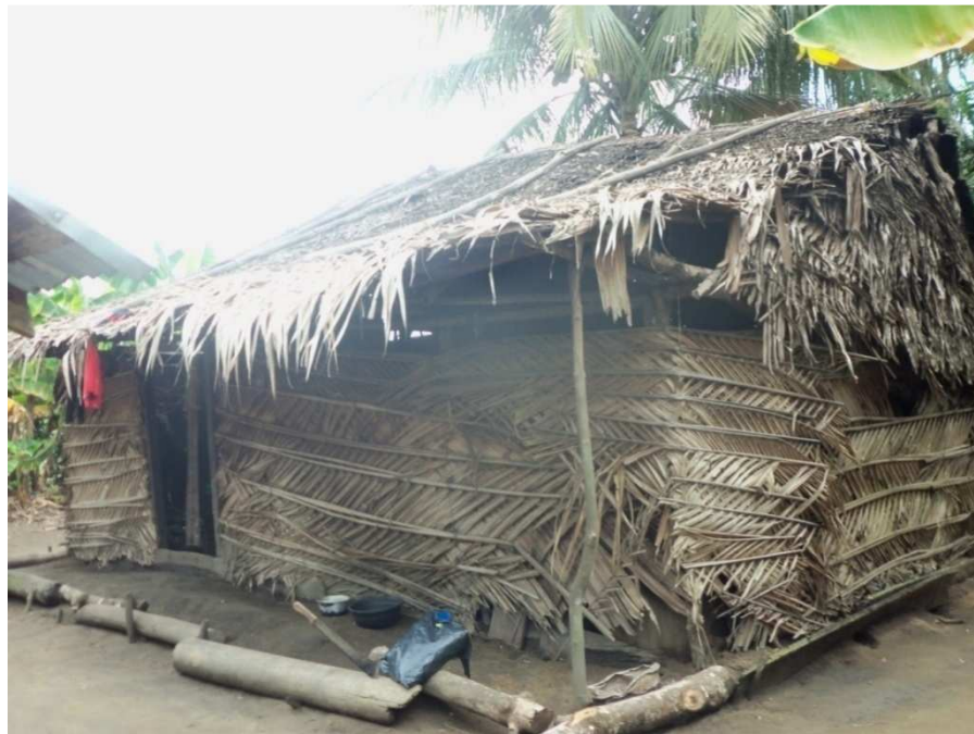
Fig.31. Atelier de fumage construit en feuille de Nypa palma-pinus
