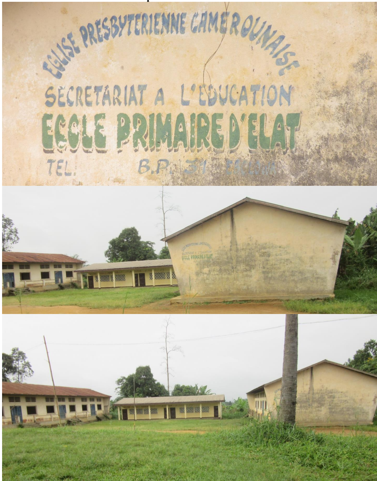
Photo 5: Vue partielle de l'école Primaire d'État
