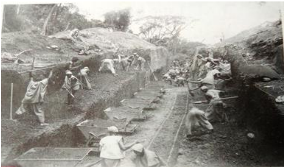
Photo 9: chantier de construction de la voie ferrée Congo-Océan en 1921
