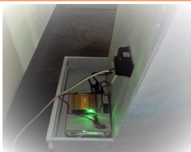
7) Installation du système solaire PV
