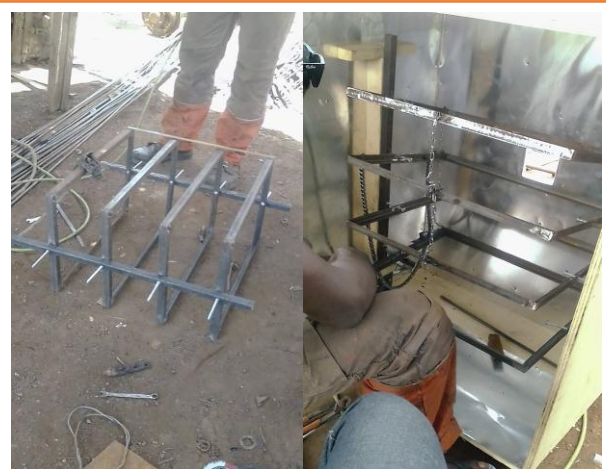
4) Soudure des supports pour claie en acier
