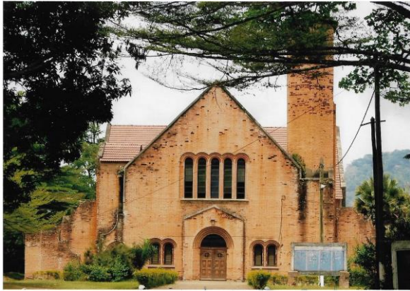
PAROISSE EPC D'ELAT en Brique de Terre
