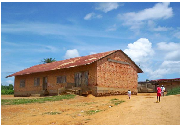
MAISON EN BRIQUE AU QUARTIER ODIN
