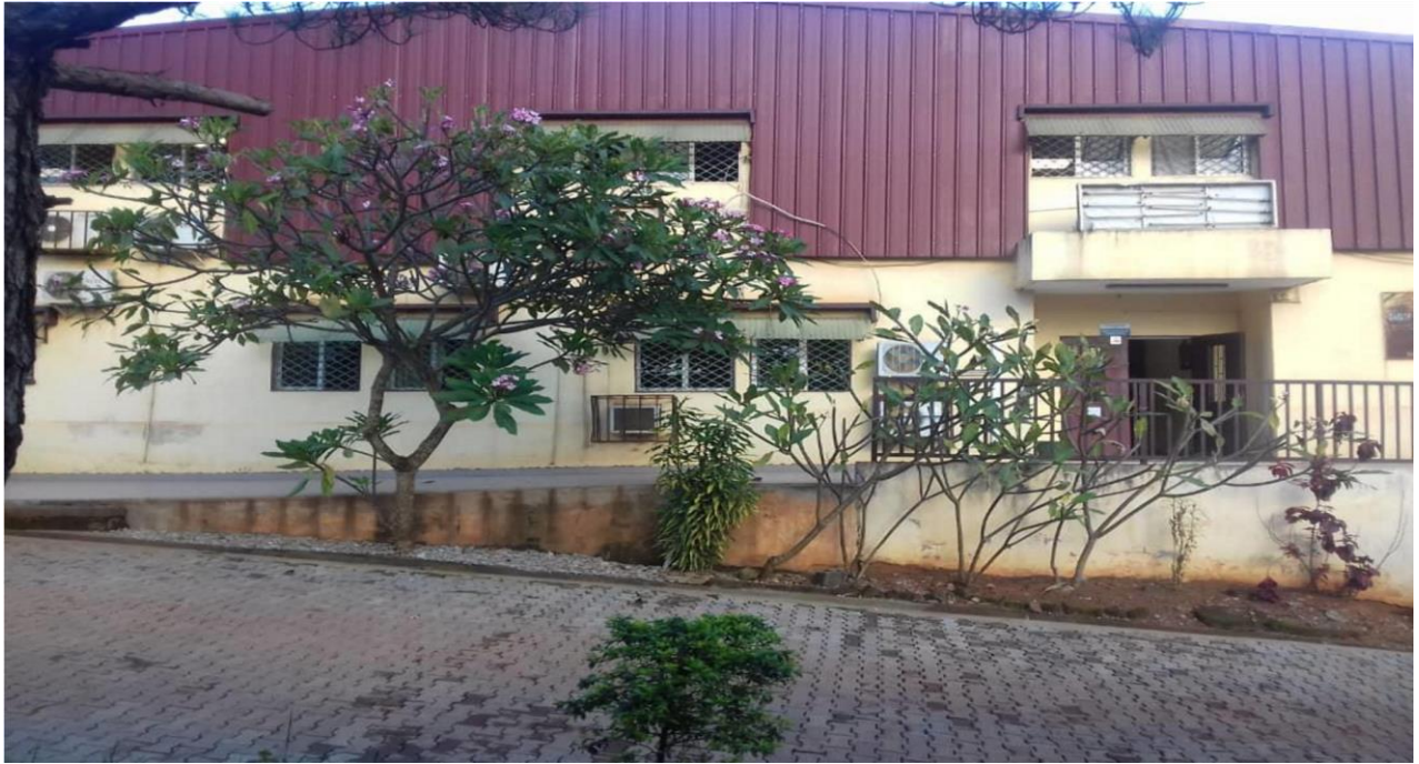
Annexe 4 : Bâtiment A vue de face
