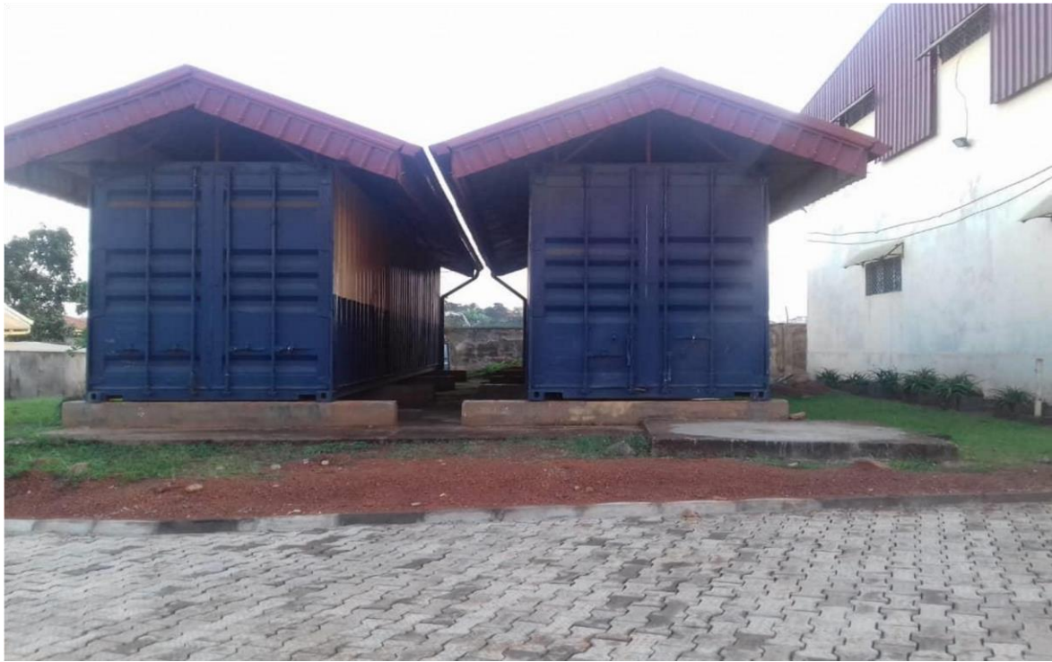
ANNEXE 8 : les containers
