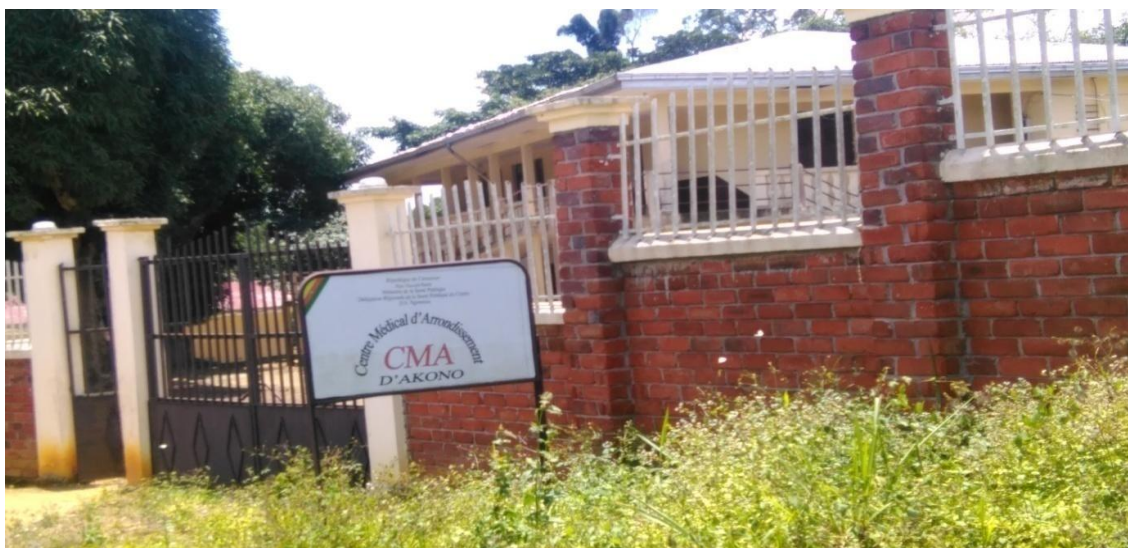
Photo 21: Façade du centre médical d'Akono.
