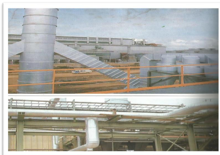
Photo 9 : Chaudière à déchets de bois et épuration des gaz d'échappement de l'usine CELLUCAM (Edéa)
