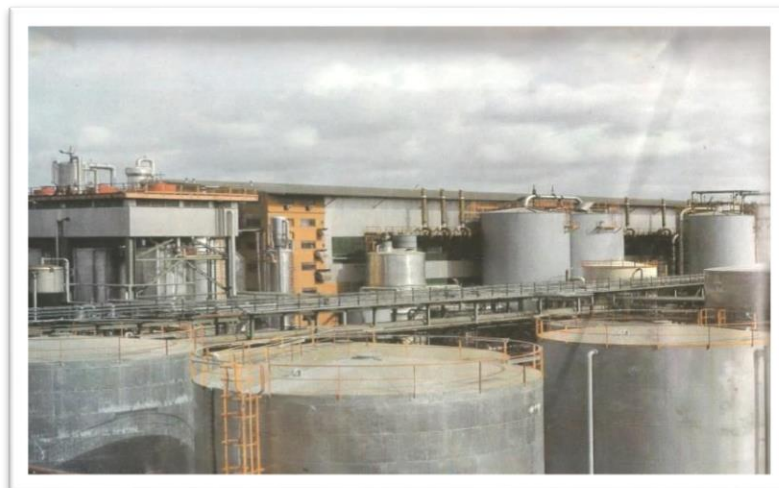
Photo 10 : Atelier de cuisson et ligne de fabrication de pâte de la CELLUCAM (Edéa)
