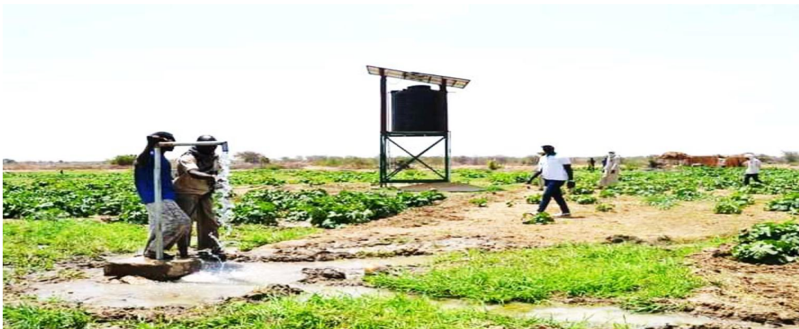
Photo 9: château d'eau potable financé par le PARSAT/FIDA
