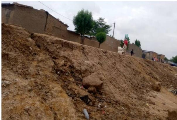
**Photos 6: rupture quasi-totale de la digue au milieu**
