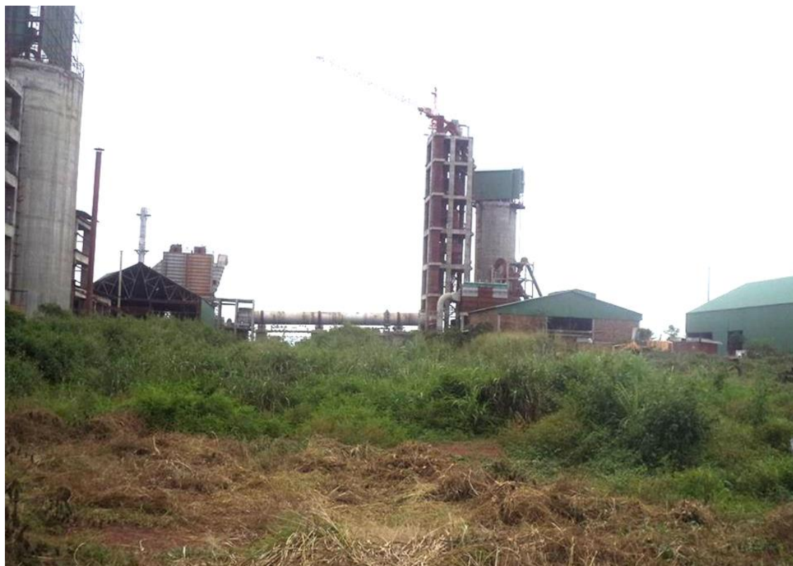
Figure 39 : Vue paromanique de la cimenterie de Nzila
