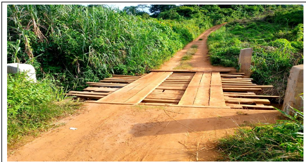
Photo 13 : Pont sur la rivière Yega (village Tom).
