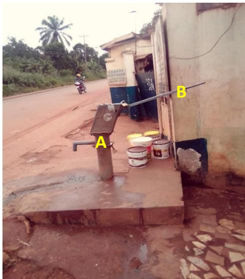
*Ce forage(A) fonctionne grâce à l'énergie motrice humaine (B), il a été aménagé par le MINEE en vue de faciliter l'accès des populations à l'eau potable. Le Comité d'Animation et Développement en assure la gestion à travers a maintenance et l'entretien des installations, la définition des heures de puisage par les usagers (06h-10h et 16h-18h).*
