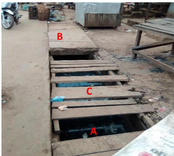
*Ce caniveau engorgé de déchets divers (A), pas curé, est totalement hors d'usage rempli d'eaux usées (A) car les eaux usées ont du mal à y circuler. Faute de dalettes (B) définitives en béton armé, les populations riveraines y ont aménagé des dalettes précaires flottantes (C), qui ne résistent ni aux poids des véhicules, ni aux intempéries, laissant des vides (A).*
