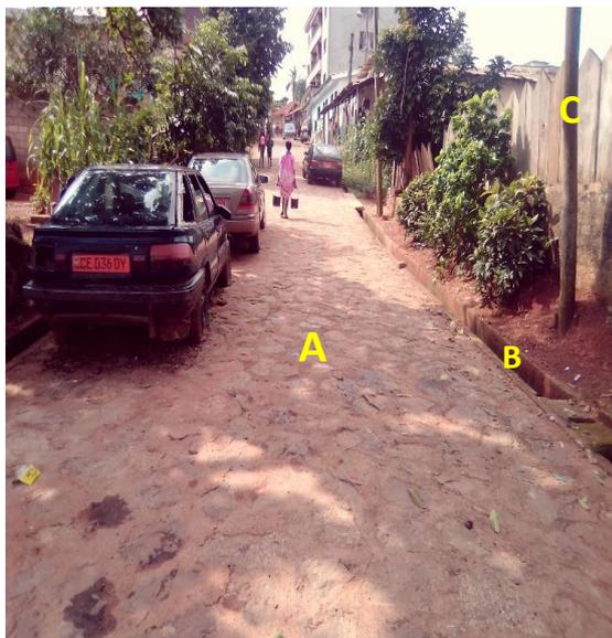
*Rue bien aménagée pavée en pierres (A) dotée de rigole bétonnée (B) et d'un poteau électrique équipé d'éclairage public (C).*
