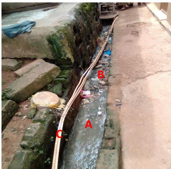
*La rigole (A) sert de réceptacles des déchets divers (B) en l'occurrence les eaux usées domestiques (A) et ordures ménagères (B), véritables poubelles. Elle sert également de dispositif d'adduction d'eau potable (C).*
