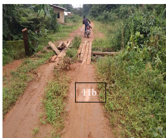
Pont aménagés par les transporteurs sur la route de Bassoumdjang
