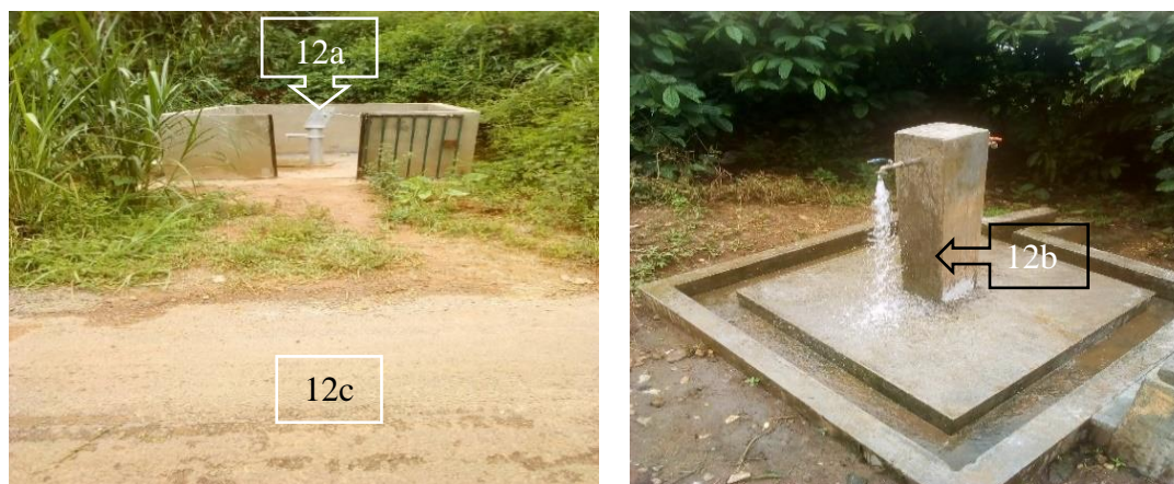
Points d'eau aménagés respectivement à Mangou, et à Bassoumdjang chefferie Ngassam, juillet 2020
