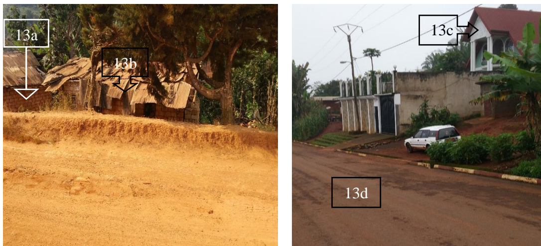
Maison en état de dégradation à Femtchuet, quartier NDJEUMACK Ngassam, décembre 2021
