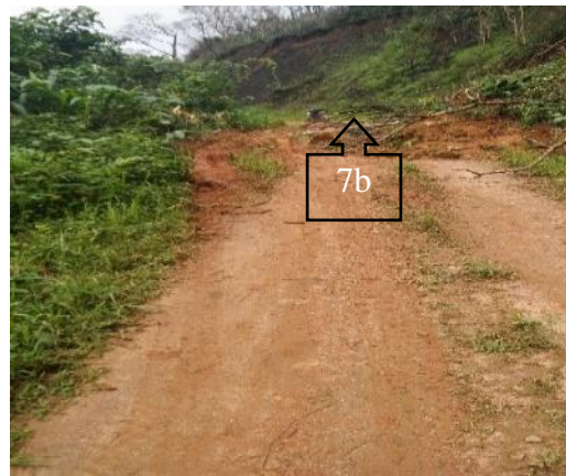
Eboulement sur la route de Bassoumdjang. Ngassam, juillet 2021
