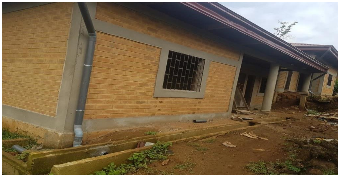
Photo n° 16 : Bloc des salles de classe du CMPJ de Ndobian
