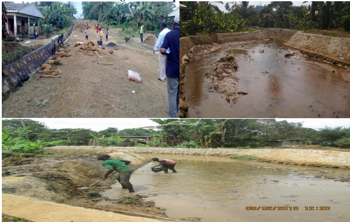
Photo n° 20 : Travaux de recalibrage des berges de drain de la Cow water au quartier Fiango à Kumba par la méthode HIMO
