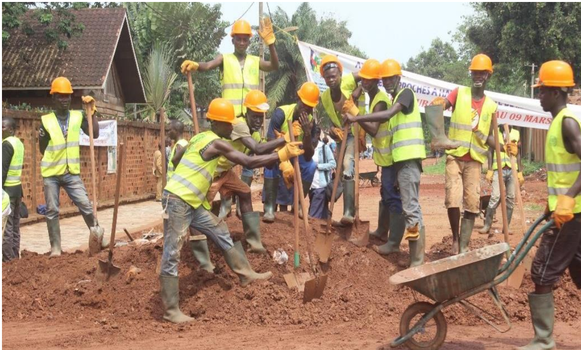
Photo n° 11 : Travaux routiers dans un chantier HIMO du MINHDU dans la commune de Tibati
