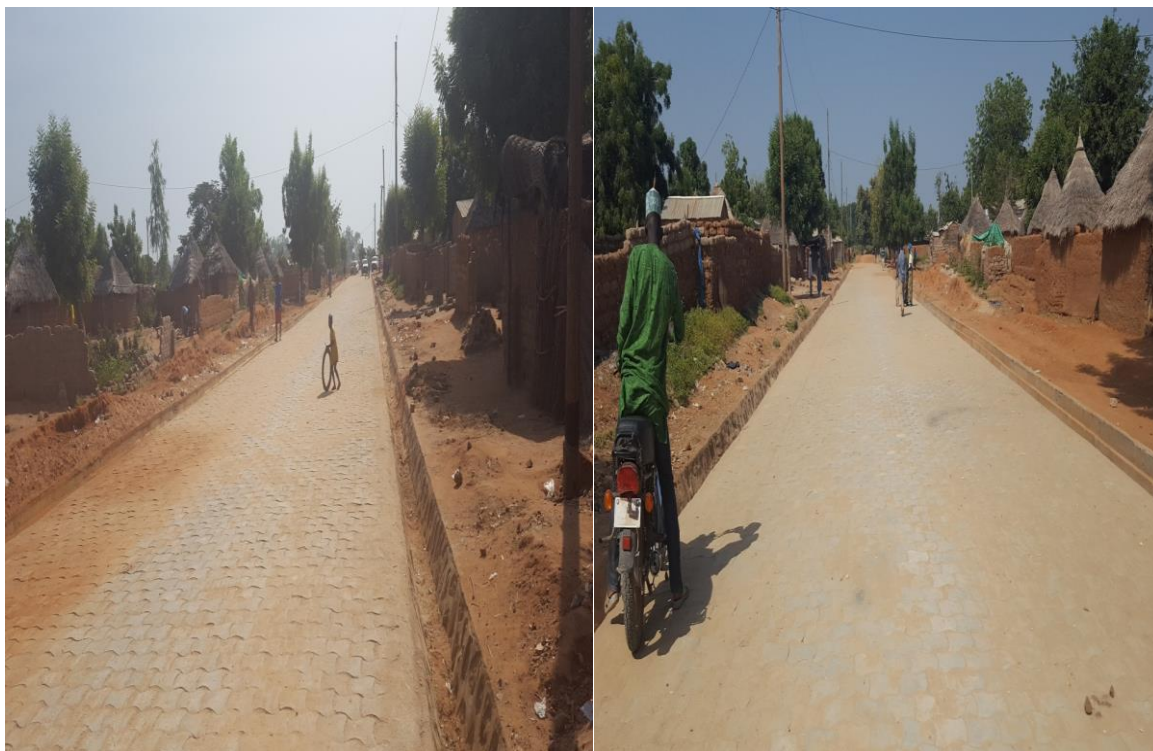
Photo n° 12 : Une vue de la voie de desserte revêtue en pavés par les jeunes dans la Commune de Garoua 3 ème
