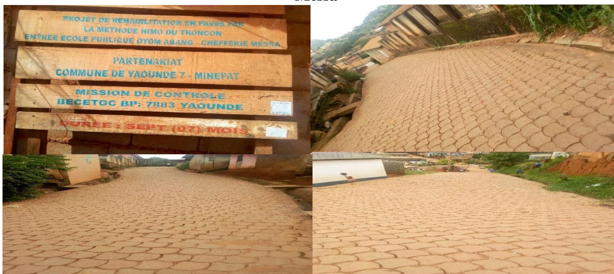
Photo n° 21 : Pavage de la desserte Entrée école publique Oyom-Abang- Chefferie Messa
