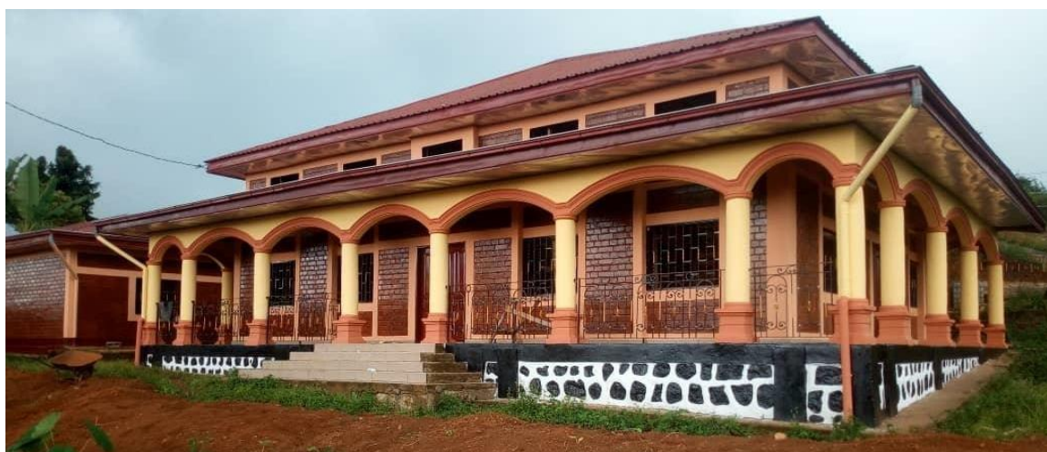
Photo n° 17 : Bloc administratif construit par la méthode HIMO CMPJ de Ndobian
