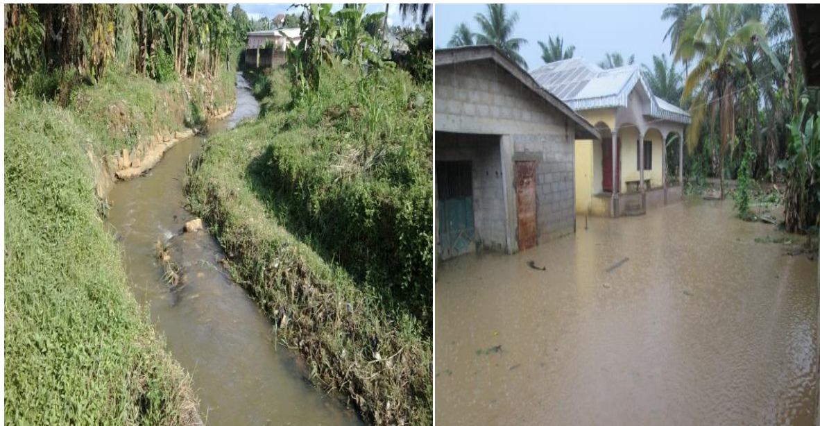
Photo n° 19 : Une vue de la cow water et ses dégâts sur le vécu des populations lors des inondations
