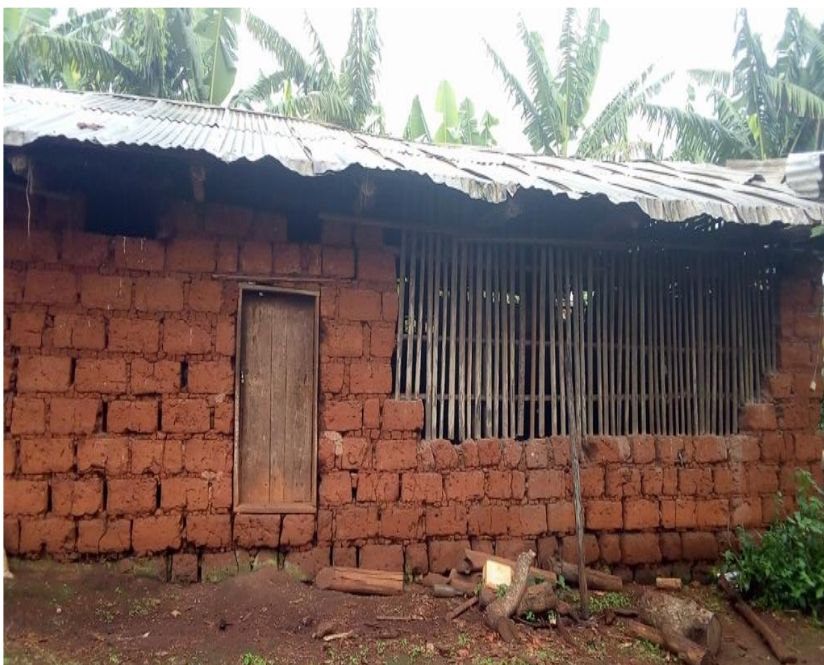
Photo 4: Ancien bâtiment de production du GIC solidarité de Bamendjou
