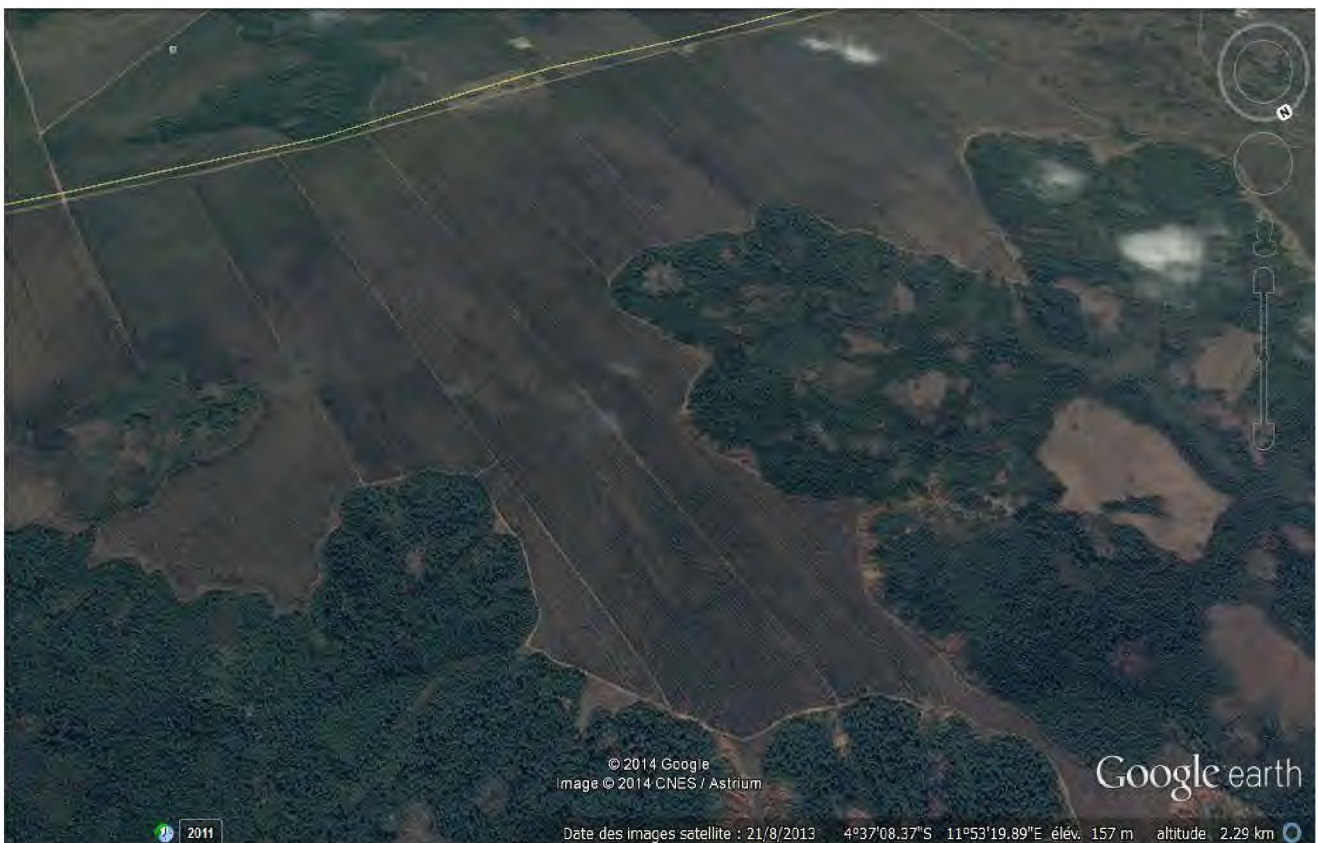
Figure.33 : Configuration actuelle des parcelles d'eucalyptus débouchant sur les cirques d'érosion vers Kondi (Source: Google Earth, 2013)
