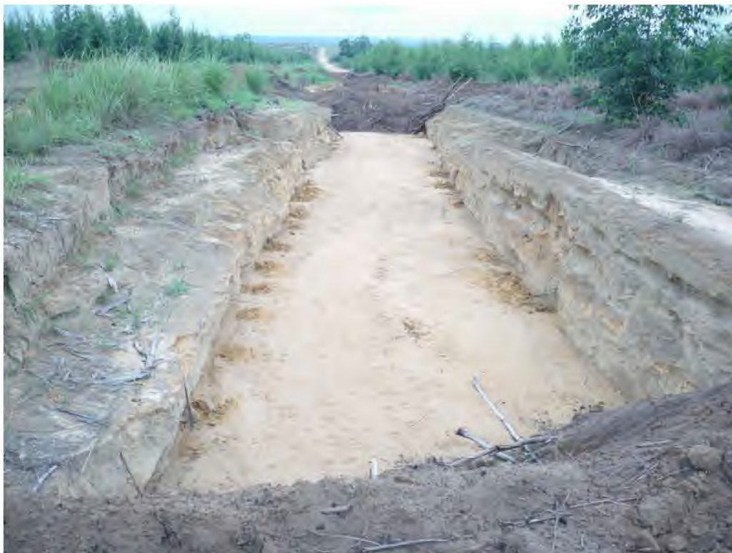
Photo 31: Stabilisation latérale d'une piste à Kondi (Cliché Mayima, 2013).
