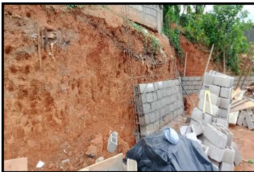
Photo 3 : Construction des murs de soutènement en dur à Mendong
