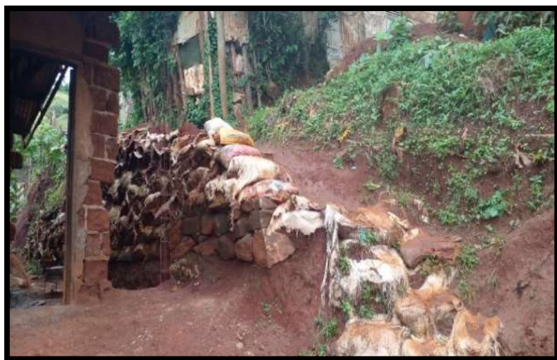
Photo 4 : Empilement des sacs de sable à Mewoulou
