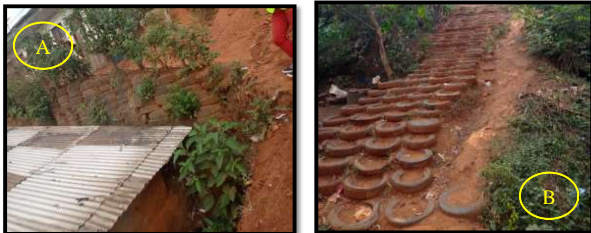
Planche 6 : Techniques d'adaptation aux pneus usagés rembourrés de terre.
