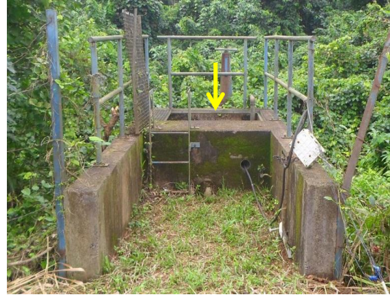
Photo 35. Dispositif abritant la pompe de captage d'eau brute
