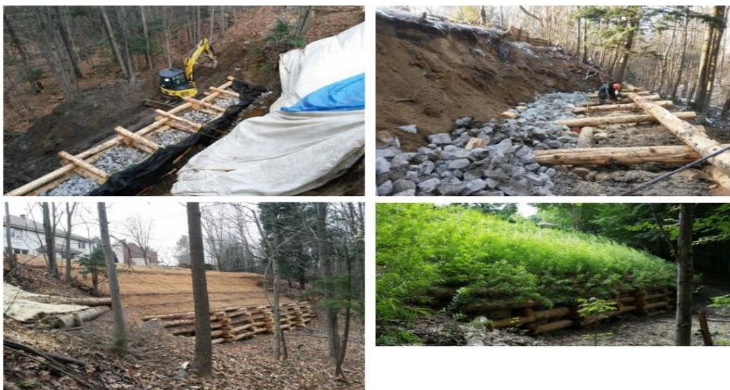
**Planche Photographique 23:** Mise en place de caissons végétalisés à double paroi surmontés d'un lit de plants et plançons. État du site après les travaux. Hauteur totale de l'ouvrage : 7 mètres.
