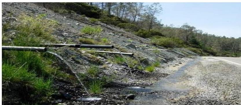
**Figure 89:** Technique du drainage du talus par barbacane.
