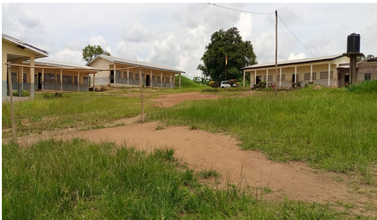
Photo 3 : Vue d'ensemble du Lycée de Mengama.
