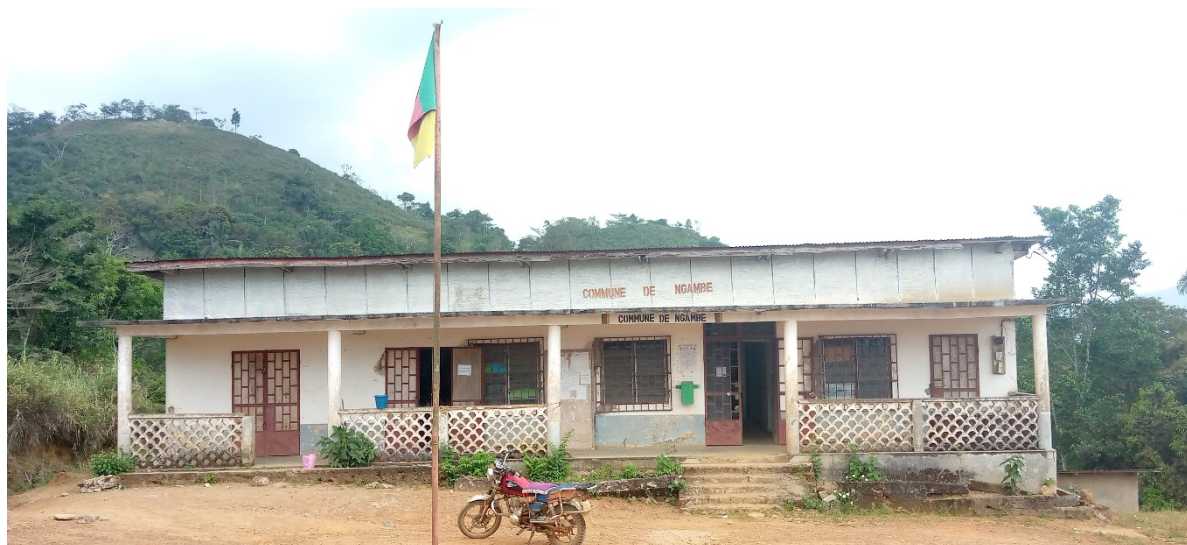
Planche 2 : Vue de la Mairie de l'arrondissement de Ngambè.
