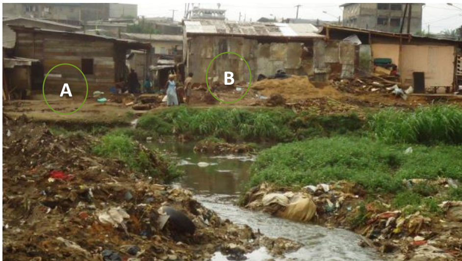
Photo 7 : les maisons construites en matériaux provisoires à Makèpè Missokè
