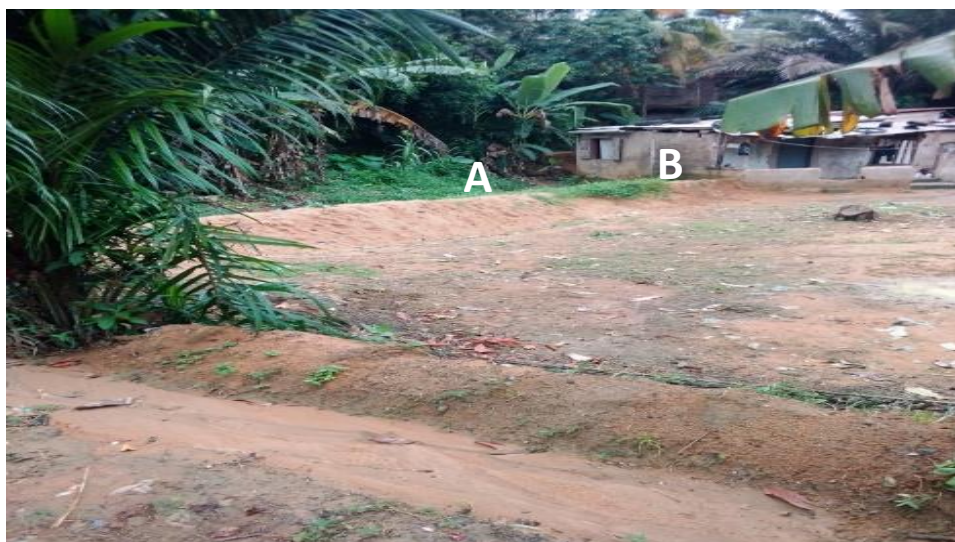
Photo 4 : construction sur le passage d'un cours d'eau. À Beedi.
