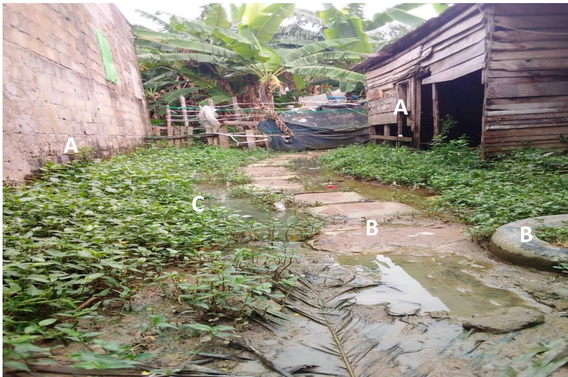
Photo 6 : Construction en zone marécageuse à Beedi.
