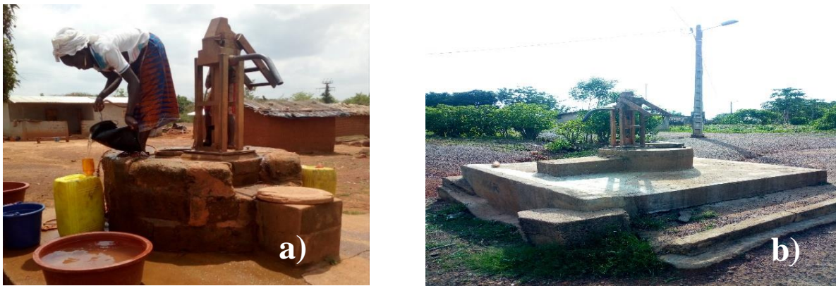
Figure 37 : a) Pompe hydraulique transformée en puits à Gouabafla (Centre du bassin versant) ; b) Pompe hydraulique non fonctionnelle à Brakaguhé (Sud du bassin versant)
