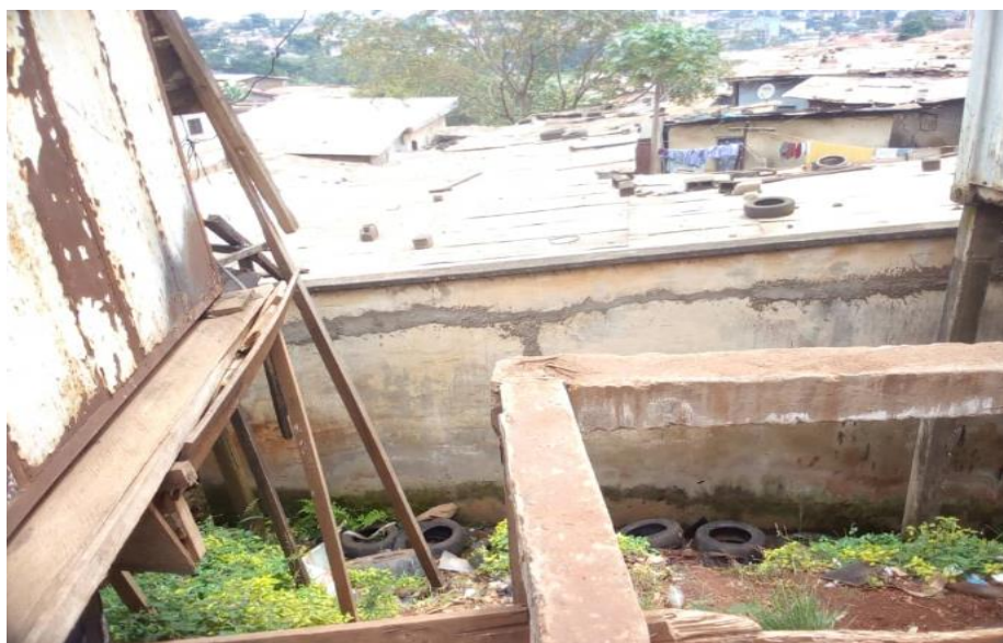
Photo 4 : pneus usés utilisés pour la protection d'une toiture de maison
