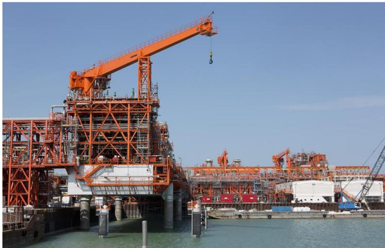
Figure 6: Une unité de séparation du brut sur l'une des îles artificielles du champ de Kashagan, au Kazakhstan 2014 (ROUSSEL MARC – TOTAL)
