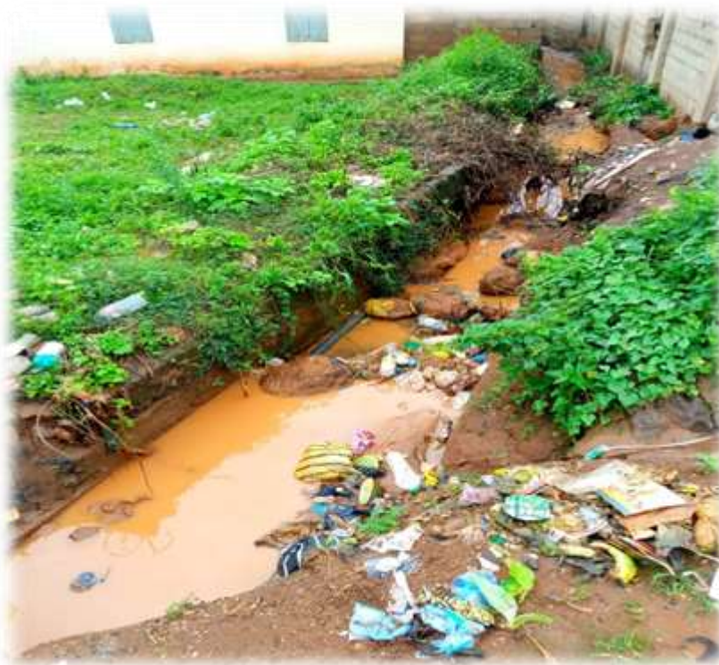
Photo 6 : Déchets éparpillés par les eaux torrentielles, au niveau du carrefour entrée mairie
