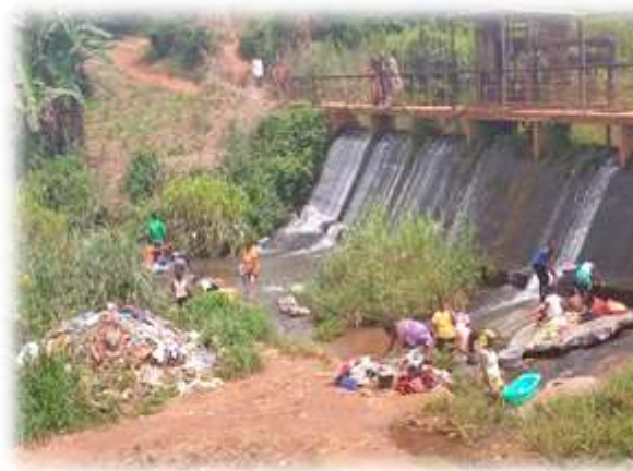
B : dépôt sauvage à côté du barrage hydroélectrique de la ville de Soa
