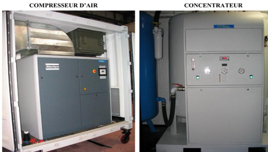
Figure 16. Compresseur d'air et concentrateur d'oxygène à l'intérieur du module [31]
