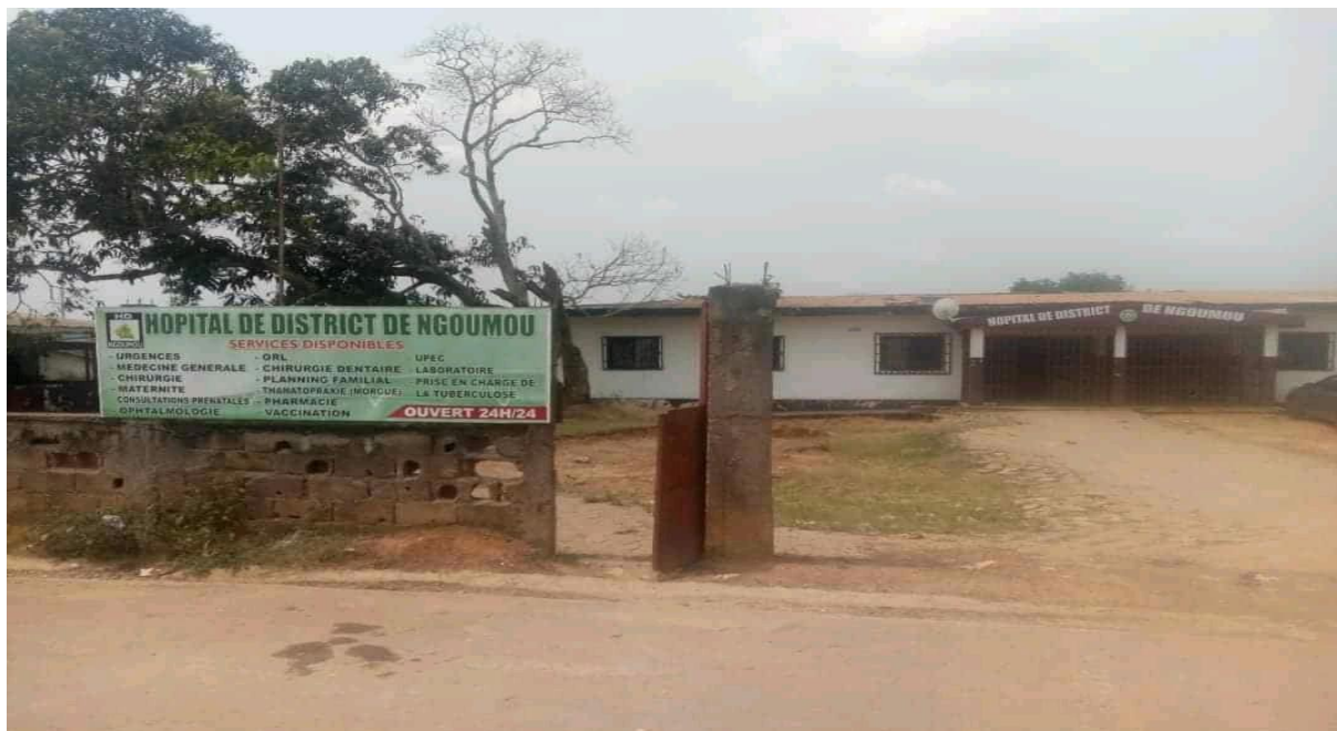
Photo 22: Façade de l'hôpital de District de Ngoumou
