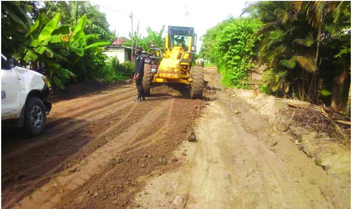
Photo N°5 : L'axe routier Otélé-Ngoumou en plein travaux d'entretien.
