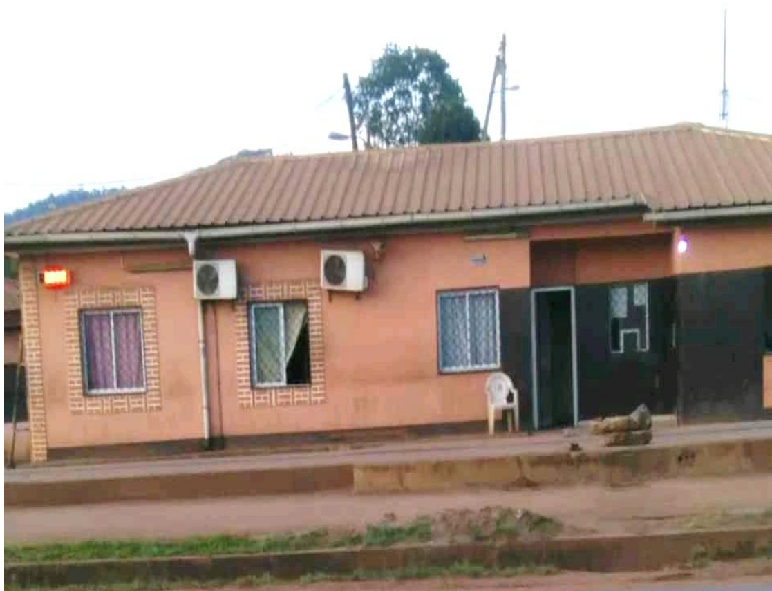
Photo N°9: Station de pesage de Nomayos (Mbankomo).
