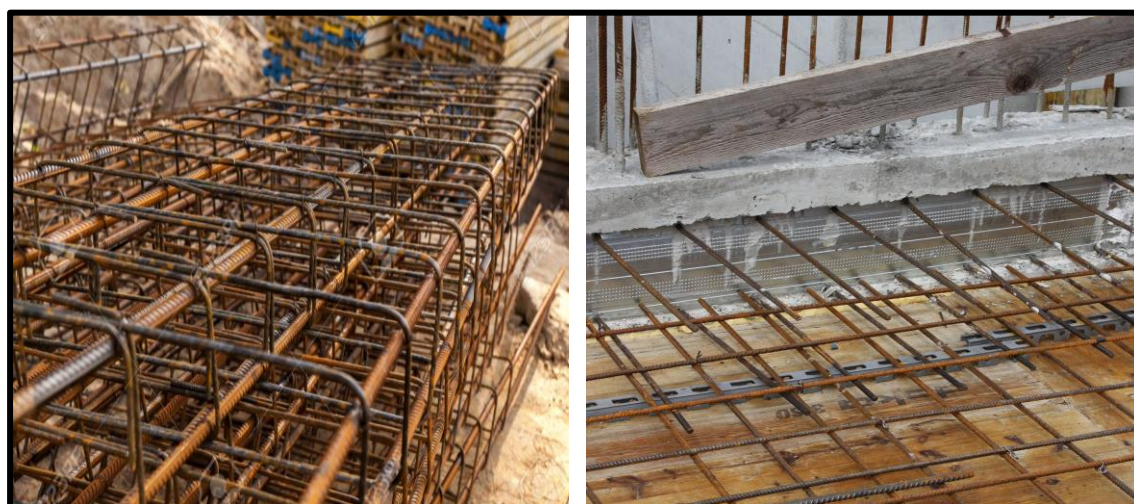
Figure 1. Armatures pour béton à base d'aciers demi-dur
