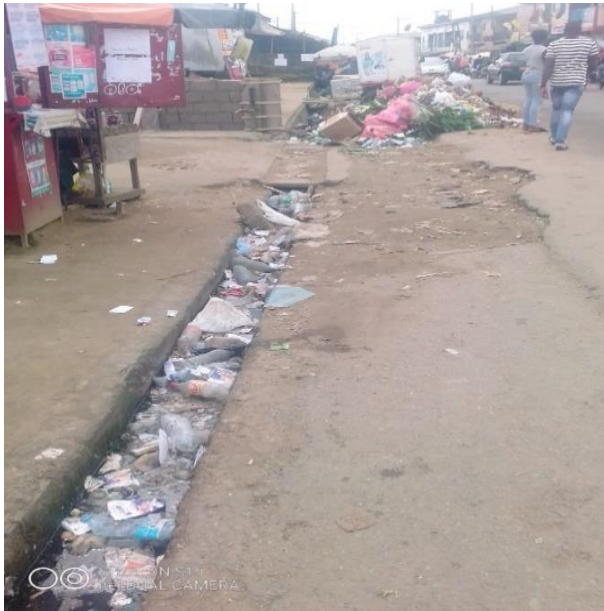
Image 14 : Canalisations obstruées en plein centre de ville lieu-dit rond-point salle des fêtes d'Akwa
