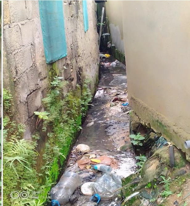
Image 7 : Ouverture des latrines canaux d'évacuation dans un petit drain
