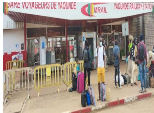
Photo 4 : Gare voyageur de Yaoundé rénovée
