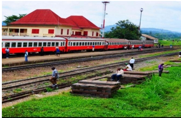
Photo 3 : Gare voyageur d'Eseka rénovée
