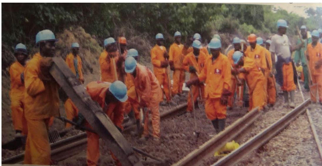
Image 8 : Rénovation de la voie ferrée sur le tronçon Edéa-Douala
