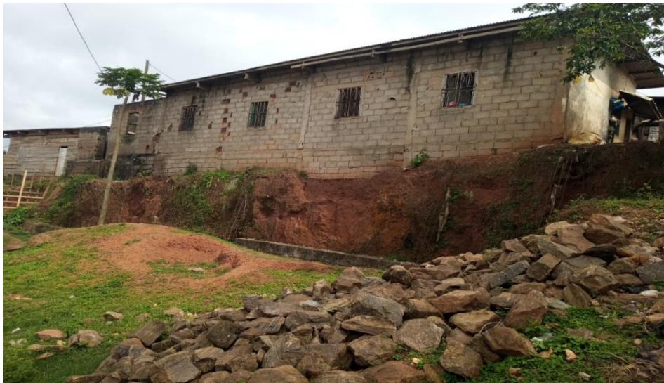
Photo 3: Maison construite sur une pente sans fondation au quartier Etoug-Ebe 1
