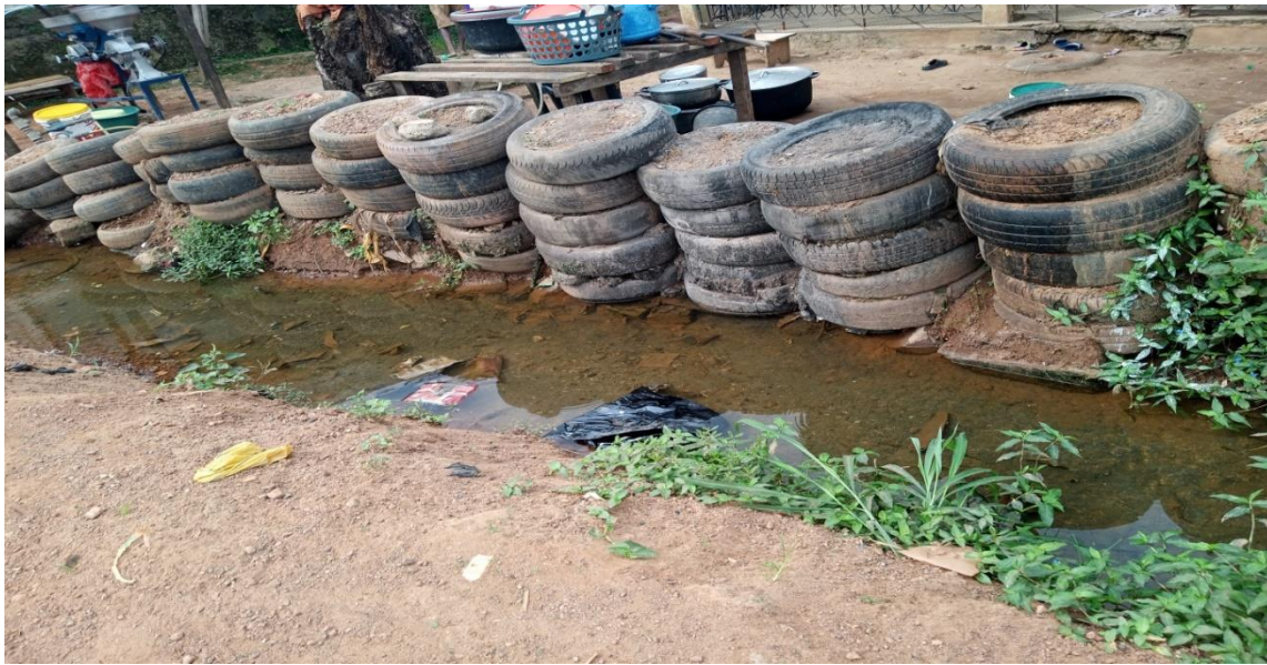
Photo 17: canalisation des eaux à l'aide de roues.
