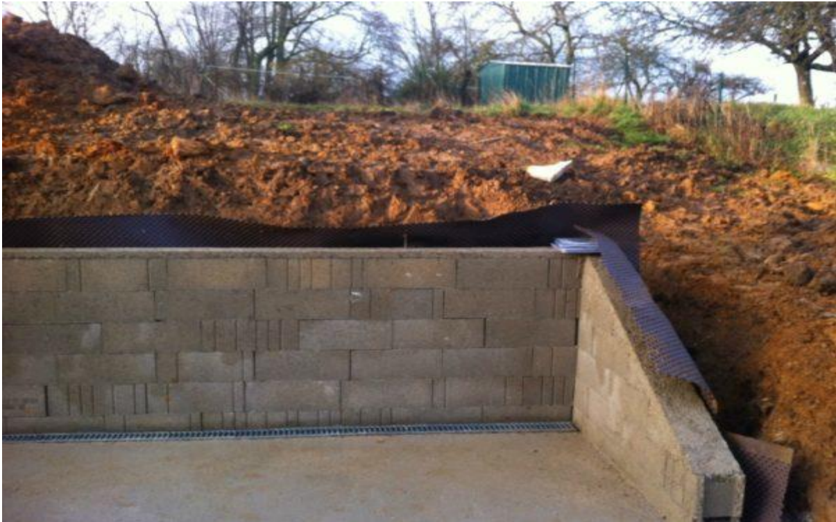
Photo 15: exemple d'un mur de soutènement
