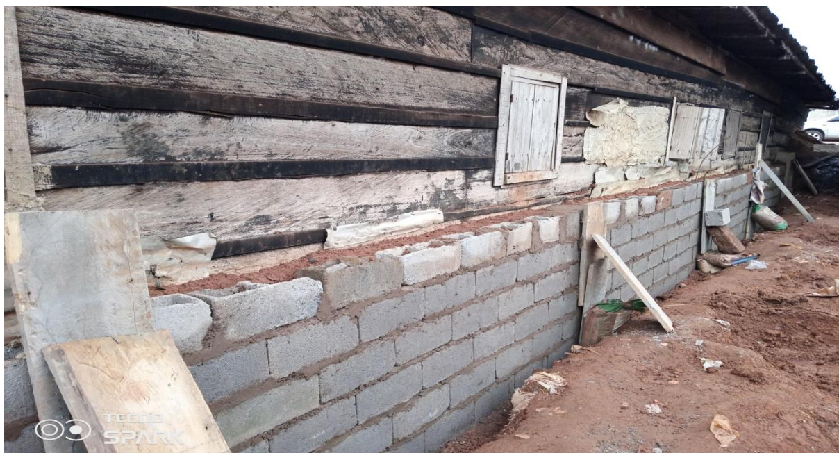
Photo 18: Elévation de mur autour d'une maison en planche
