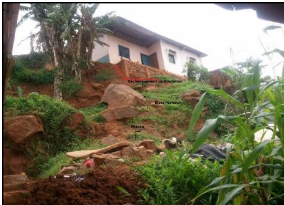
Photo 4: Surcharge au sommet d'un talus et sur un versant en pente
