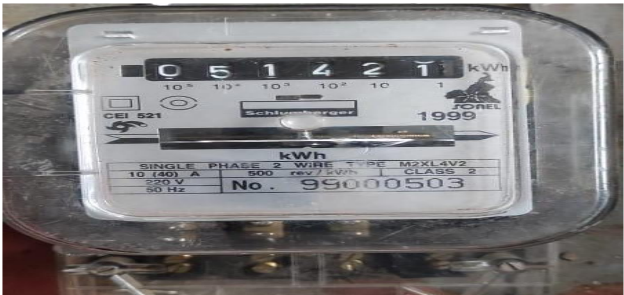
Photographie 10 : Compteur électromécanique SONEL de la Gamme 1999
