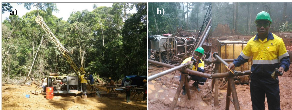
Figure 9. Site de sondage inclinés : a) Foreuse Christensen 1400's© ; b) Technique d'orientation à l'aide de Reflex ACTII et une foreuse Hydracore
