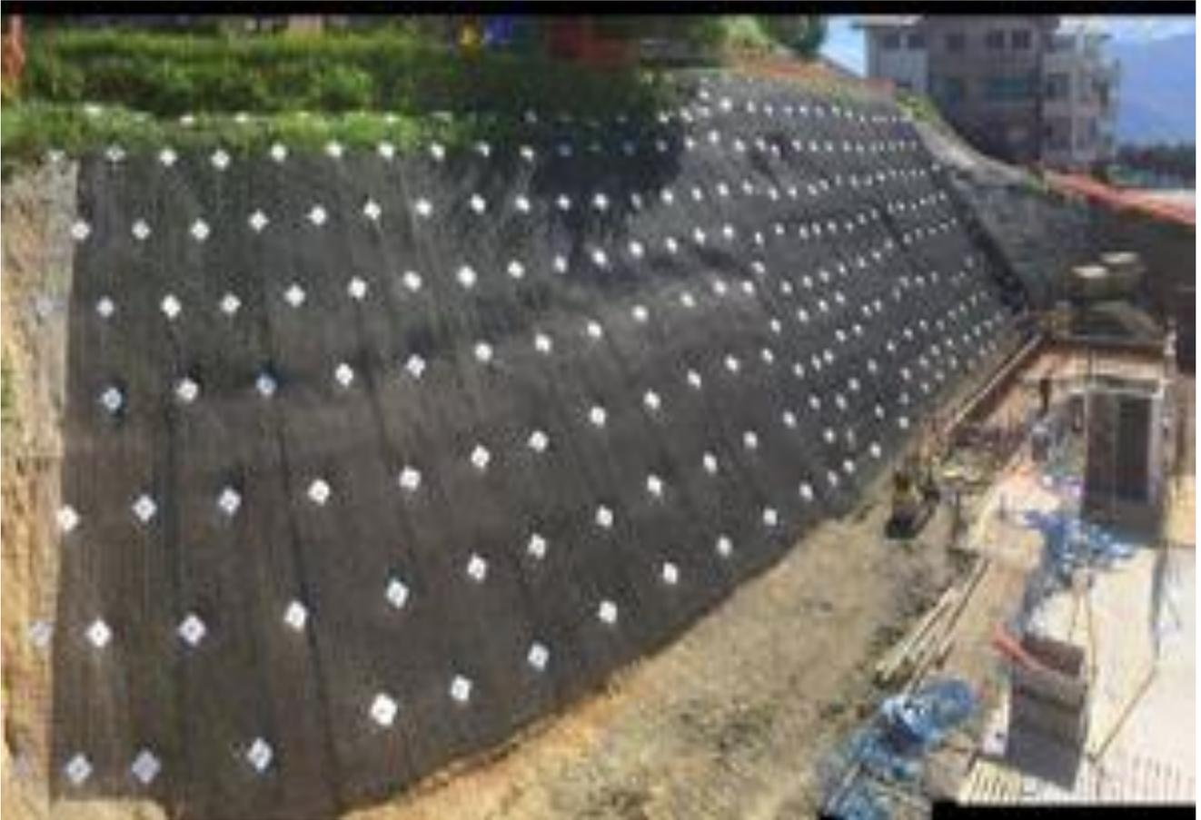
**Photo 1: versant stabilisé par clouage**
