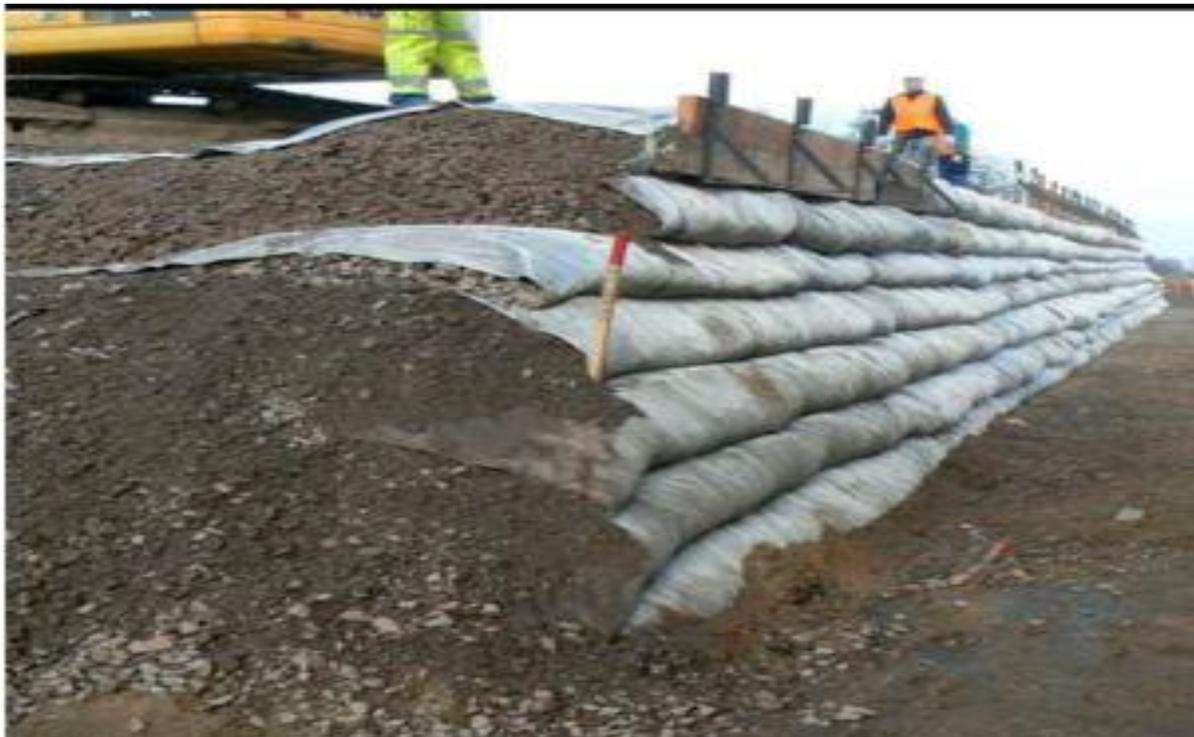
**Photo 12: talus soutenus par géotextiles source : gateway structure**
