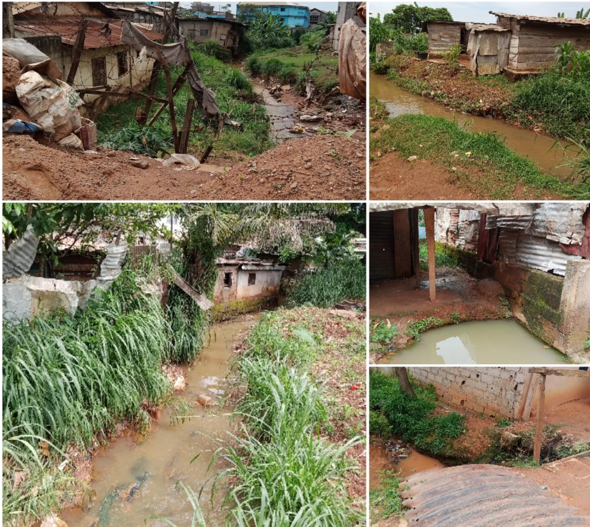
Figure 6 : Aperçu des maisons construites autour des cours d'eau et marécages à Bata-Nlongkak.
