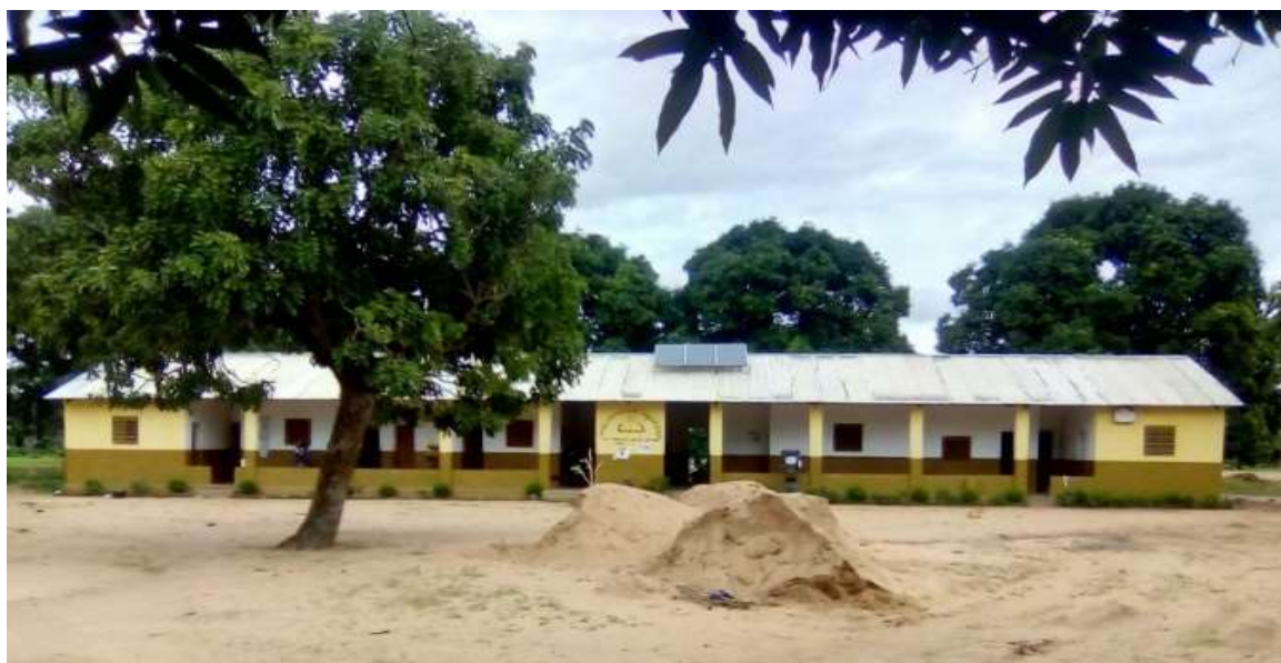
Photo 2 : Centre district sanitaire évangélique du bloc paysannat
