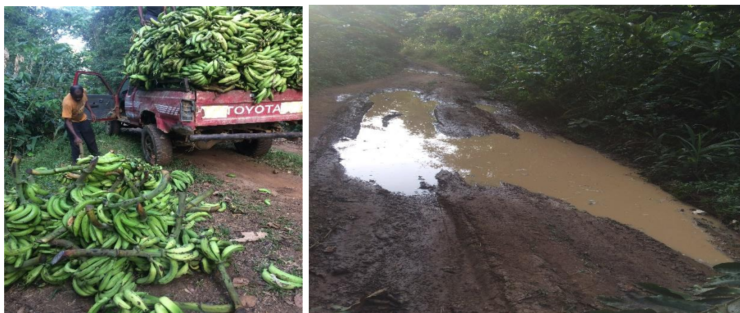
Photo 10: Une vue de la route Meka'a marché frontalier d'Abang Minko'o
