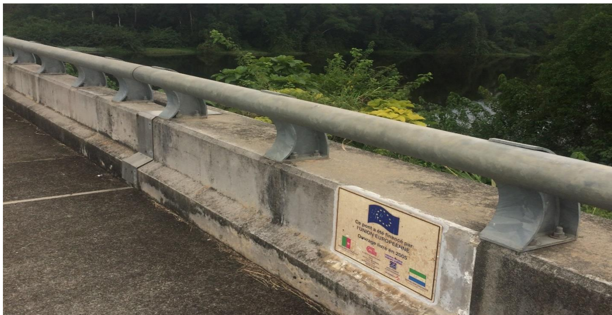
Photo 2: Vue latérale du pont sur le fleuve Ntem (frontière Cameroun-Gabon).
