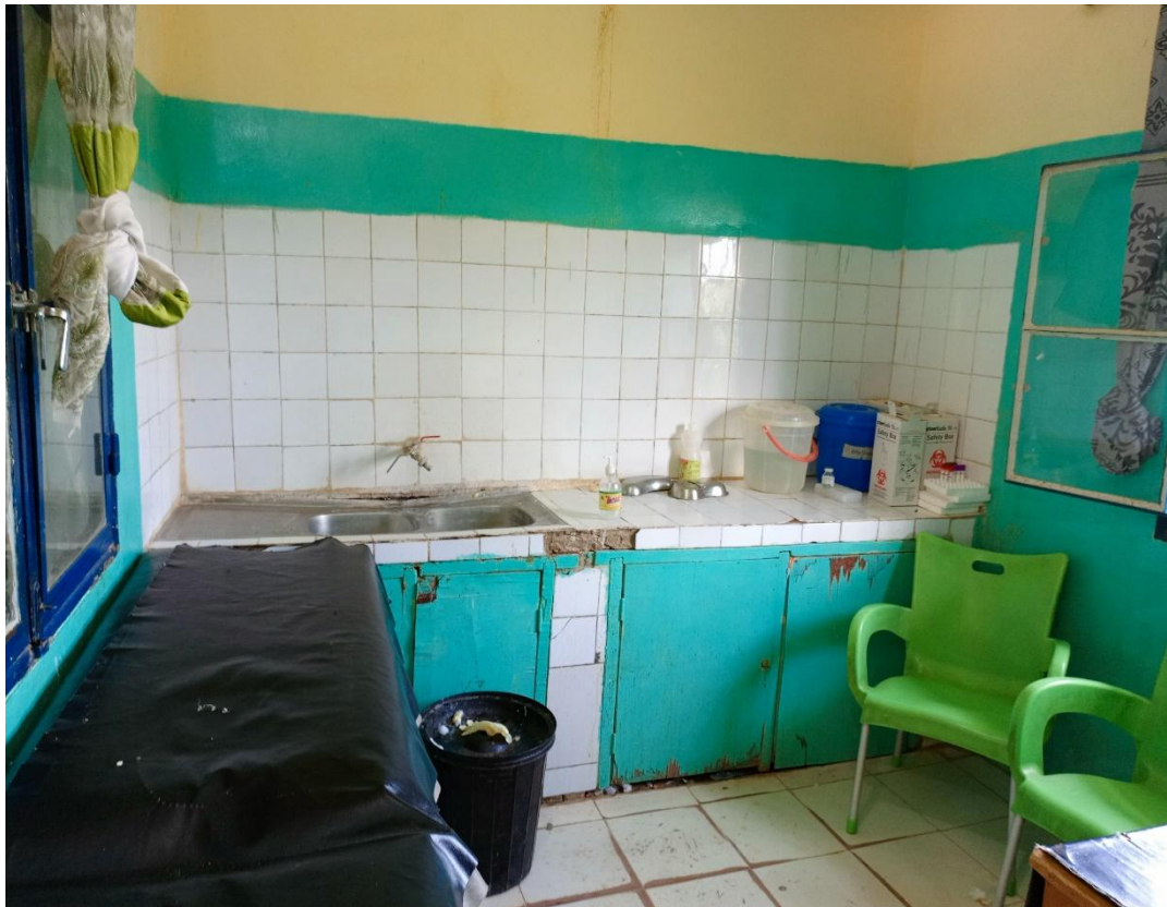
Photo N°1 : Salle de soin du service des urgences de l'Hôpital Provincial de Mongo
