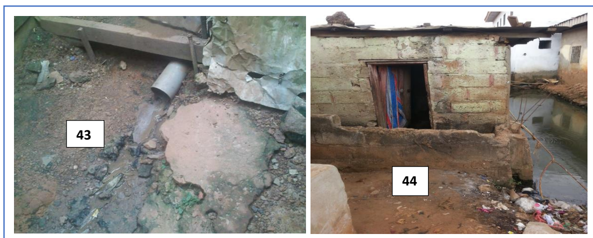
Photographie 43 : vue d'un tuyau d'évacuation des eaux usées au quartier Briqueterie
