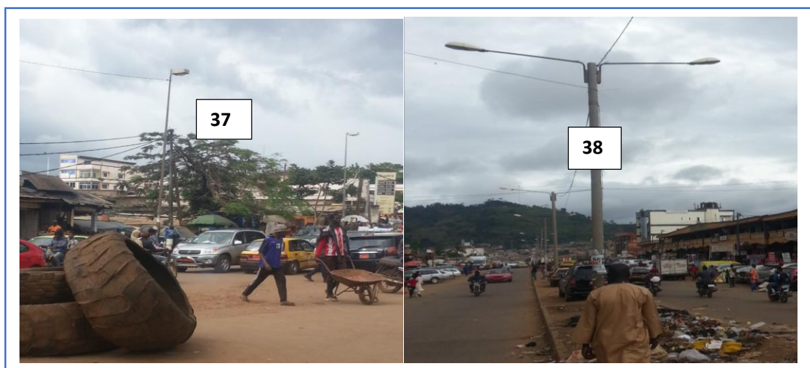
Photographie 37 : vue des lampadaires éclairant l'une des rues du quartier Briqueterie
