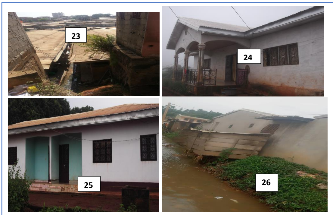
Photographie 23 : des maisons d’habitation aux murs en durs et aux toitures en tôles au quartier Briqueterie
