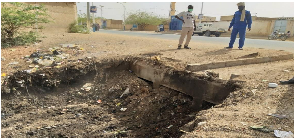
Photo 4: canal d'évacuation des eaux obstrué par des déchets
