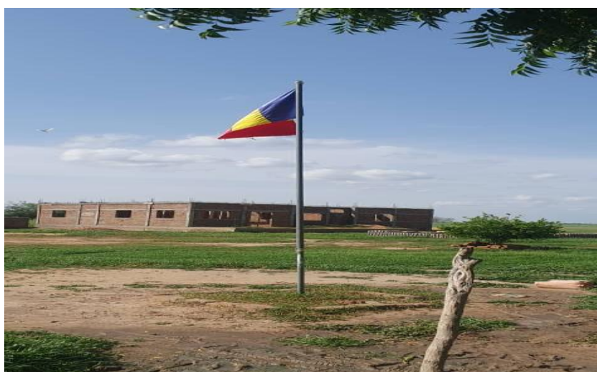
Photo 5 : La Chefferie Traditionnelle du Canton Man-Mafé en construction à Atia-Ardébe (Chef-lieu du Canton)
