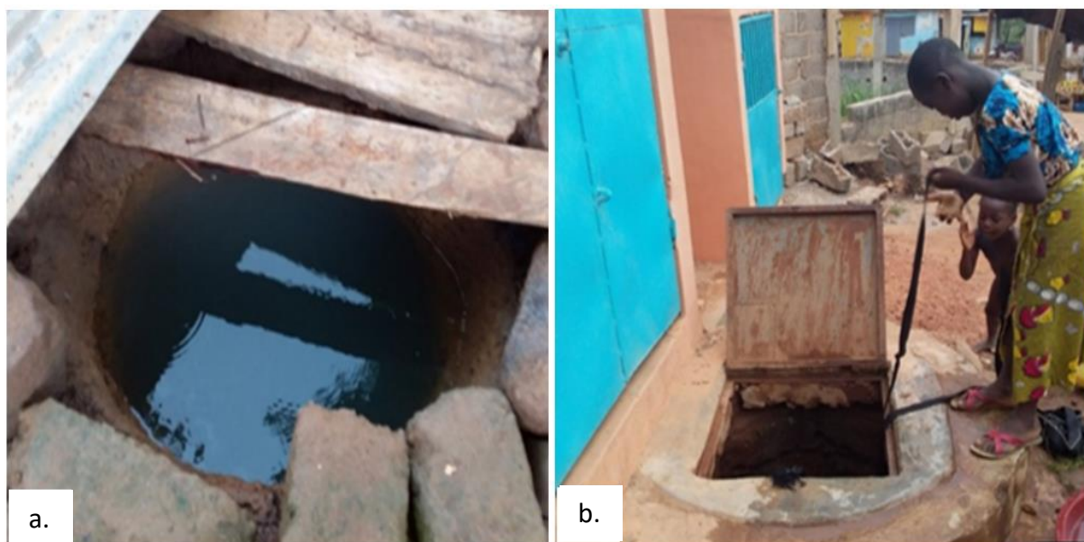
Figure 12 : Puits traditionnels captant les nappes d'altérites
