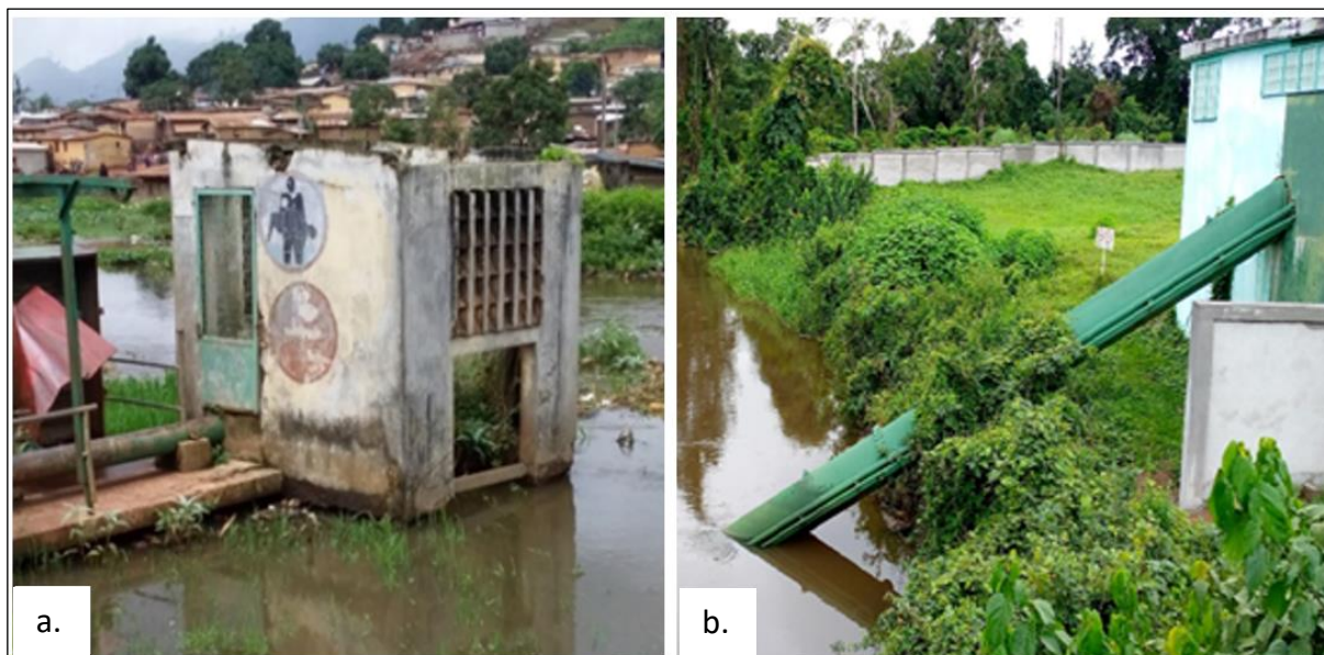
Figure 5 : Site de prélèvement d'eau de la SODECI dans la zone d'étude
