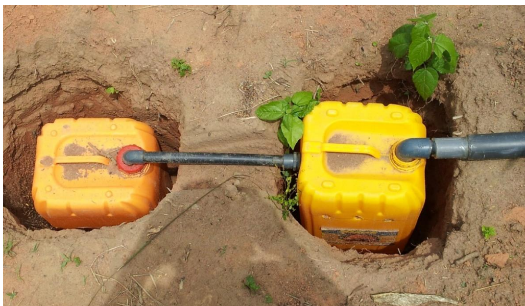
Figure 45 : Gouttière de collecte des eaux de ruissellement
