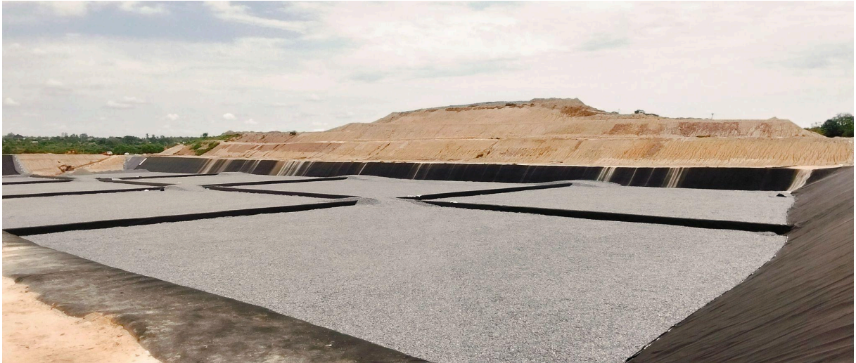
Photo 5 : Casier 2 composé de 8 alvéoles en cours de construction
