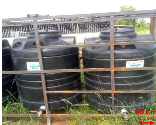
Fûts de stockage des digestats
