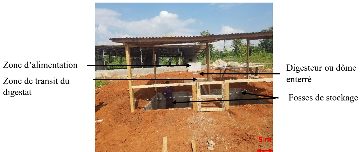
Figure 16: Différents compartiments du digesteur incluant les fosses de stockage du digestat en fin de construction
