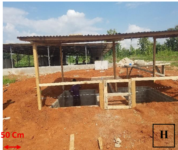
Plateforme de production de biogaz et de digestat achevé
