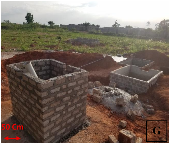
Plateforme en finition
