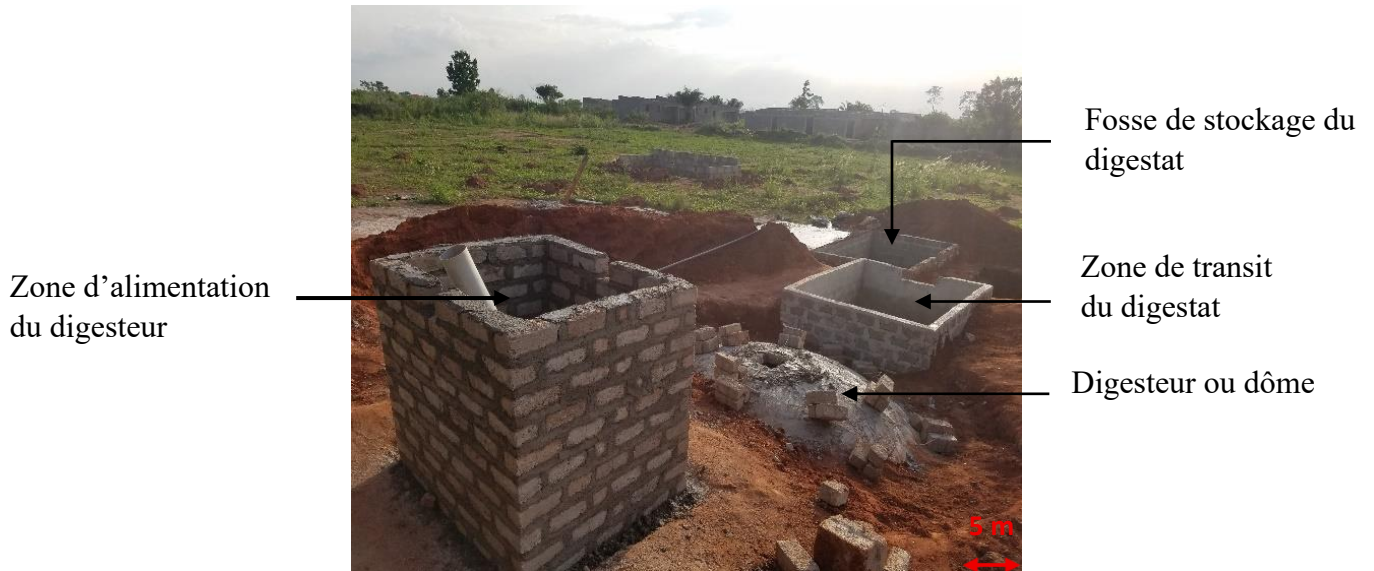
Figure 15 : Digesteur en construction
