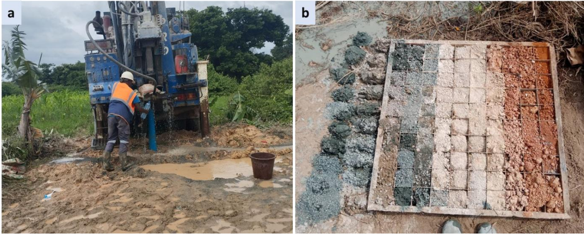
Figure 28 : Réalisation d'un forage à Daloa (quartier Bellecôte). a) foreuse et b) dépôts des cuttings à chaque mètre de l'avancement du forage
