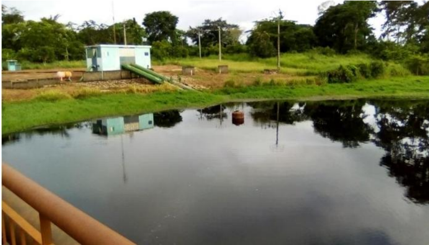
Figure 9 : Site de prélèvement d'eau de la SODECI sur la retenue de la Lobo
